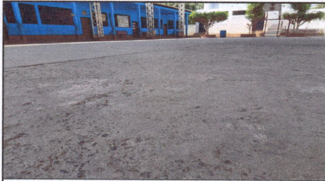
Foto 1: se hará un relleno de aproximadamente 75 centímetros y fundición debido a las inundaciones
