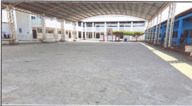
Foto 3: se hará un relleno de aproximadamente 75 centímetros y fundición debido a las inundaciones
