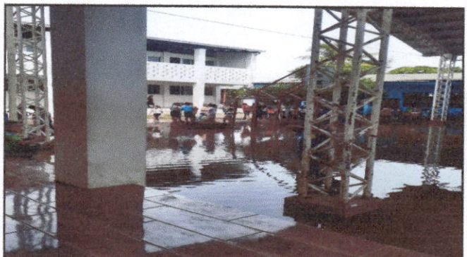
Foto 4: se hará un relleno de aproximadamente 75 centímetros y fundición debido a las inundaciones
