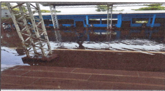
Foto 5: se hará un relleno de aproximadamente 75 centímetros y fundición debido a las inundaciones
