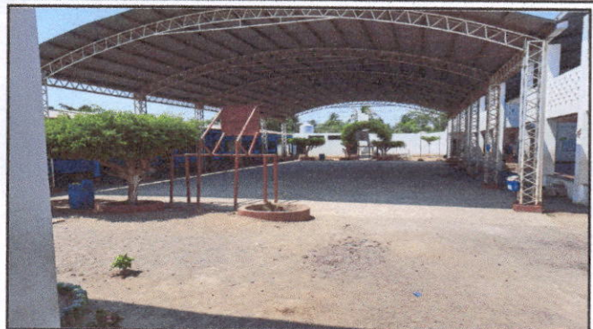
Foto 2: se hará un relleno de aproximadamente 75 centímetros y fundición debido a las inundaciones
